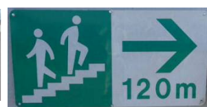
避難階段位置標識の例
