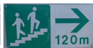
避難階段位置標識の例
