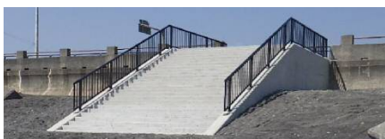
将来の堤防嵩上げ工事を考慮した東側階段
