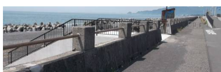
国道150号の斜路に近い東側階段
