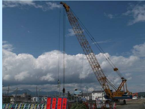
鋼矢板設置全景
