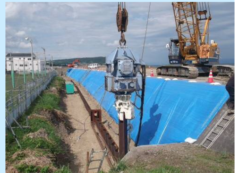
鋼矢板設置近景
